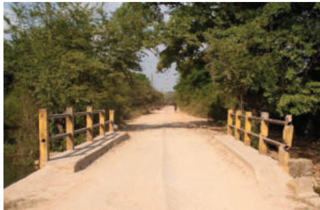
Ilustración 8: Fotografía de puente existente
