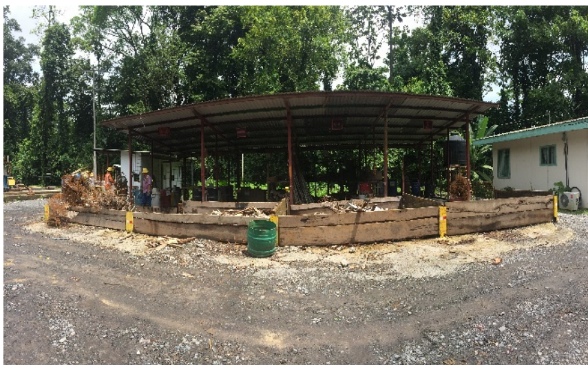
Figura 5.7.3.2. Sitio de transferencia de residuos en frente de obra.
