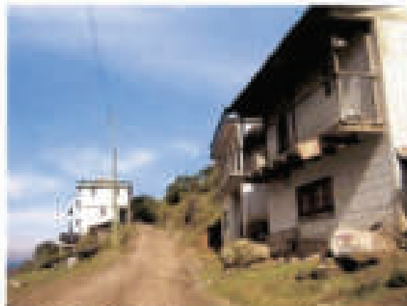
FOTO Nº 4.2 Condiciones actuales de tramo
