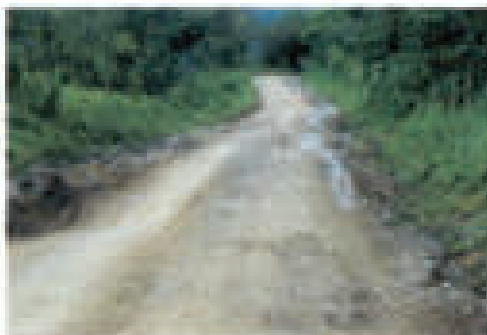
FIG. 1.3 Y 1.4 Aliviaderos superficiales de agua, donde se construirán subdrenajes.
