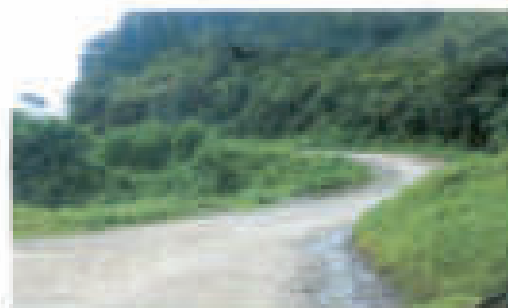
FOTO.1. Condiciones actuales de la vía
