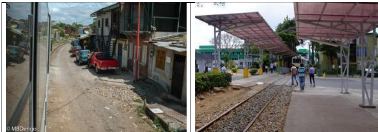
Figura 10. Zonas urbanas, comerciales y residenciales a lo largo de la línea de ferrocarril (izquierda: Tramo Atlántico-Ciruelas. Abril de 2019; derecha: Tramo Paraíso-Atlántico)
