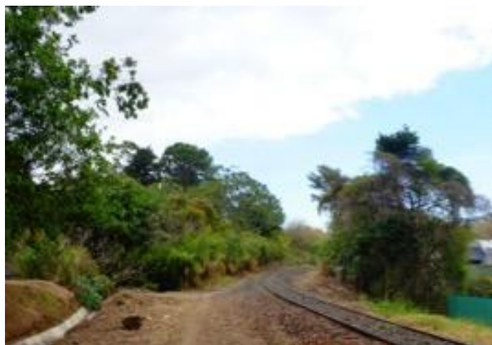
Figura 7.4. Área de matorral, ambos márgenes tramo Paraíso-Atlántico. Abril, 2019.
