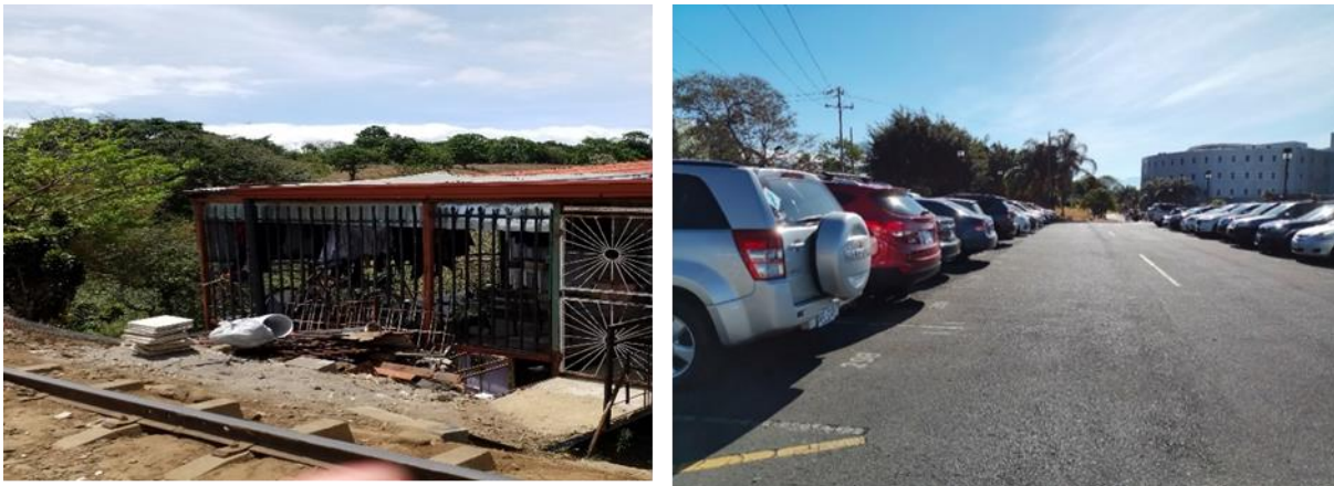
Figura 8.2. Área urbana, tramo Heredia-Atlántico a la derecha Hospital San Rafael, Alajuela- Pacifico Abril, 2019.
